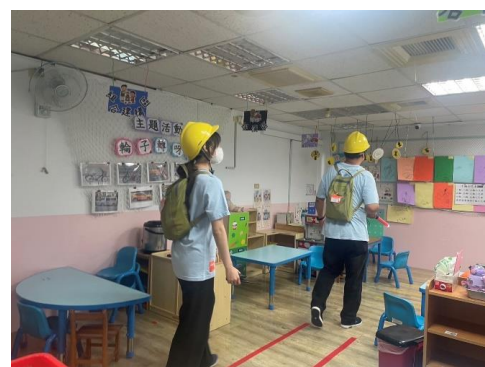
巡查園所建築物災損
