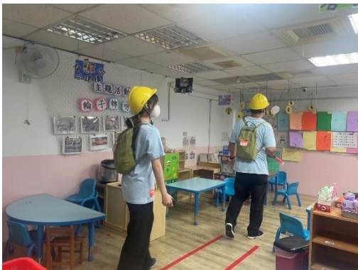
※查巡園內建築物災損。
